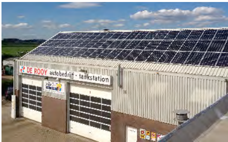
Zonnepanelen op dak werkplaats
